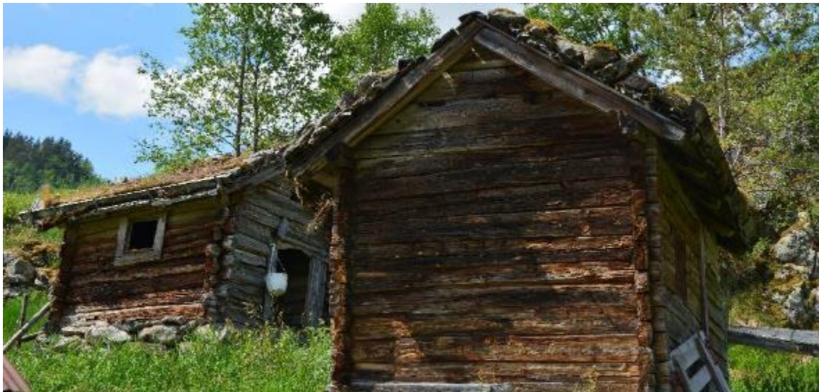
Gamle bygningar på Havrevoll
